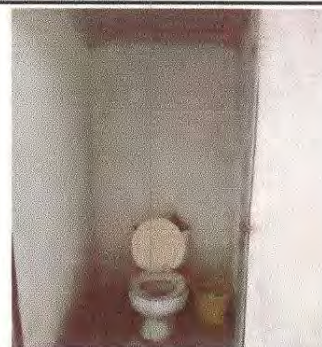
Foto 10: Sustitución de puerta y sustitución de inodoro
