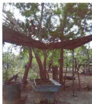
Foto 9: Cubierta de techi y estructura portante de metal
