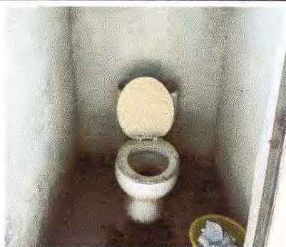
Foto 11: Sustitución de piso ceramico
