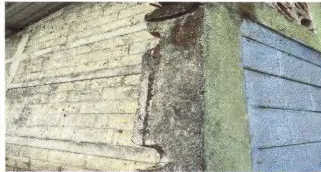
Foto 8: Sellado de grietas y fisuras en muros
