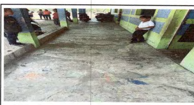
Foto 7: Sustitución de piso cerámico
