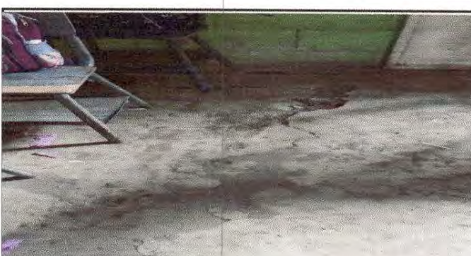
Foto 4: Sustitución de piso cerámico
