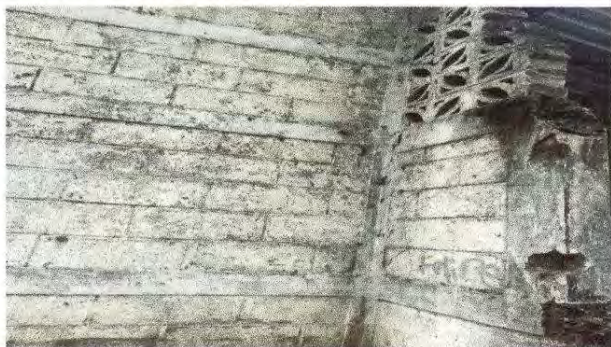
Foto 7: Sellado de grietas y fisuras en muros
