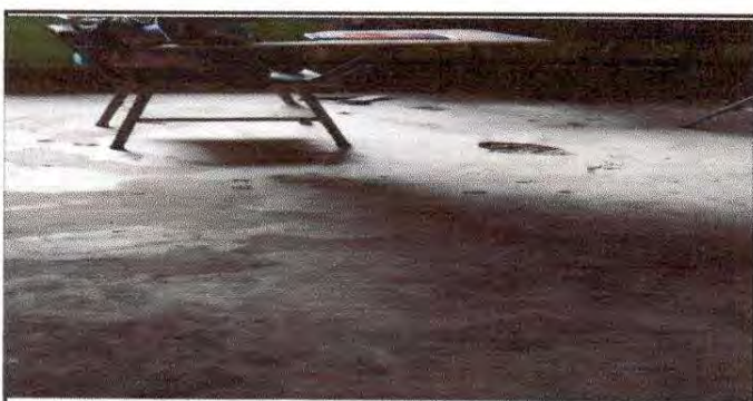
Foto 5: Sustitución de piso cerámico
